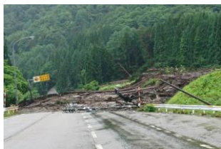
平成30年7月豪雨災害 (国道41号 古川町数河内)
