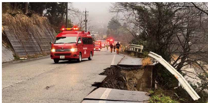
▲陥没した道路
