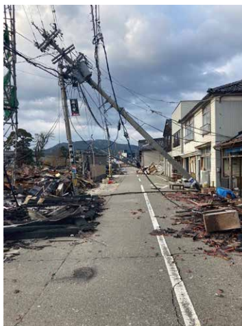
▲電柱が道路をふさいでいる (輪島市内)
