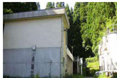
▲梨ヶ根浄水場
