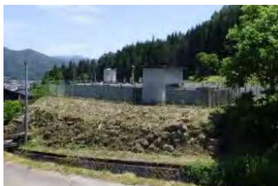
▲高野第1配水池
