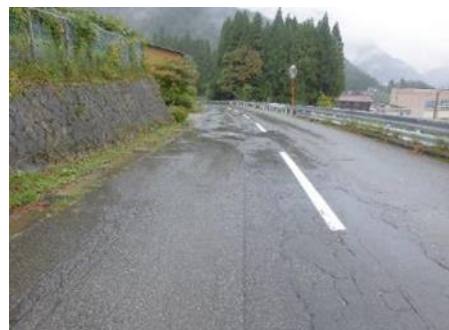
▲劣化した舗装の補修
