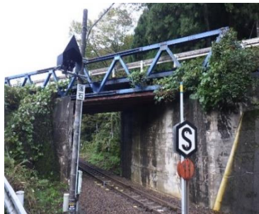
▲杉原～小豆沢線（JR跨線橋の架替）
