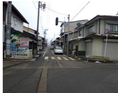
▲上金森町線（面的な側溝改良）
