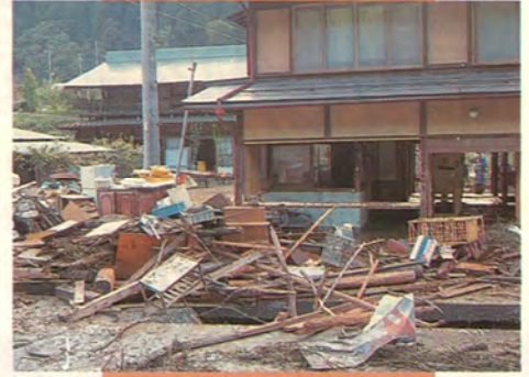
▲床上浸水した家屋（河合町）
