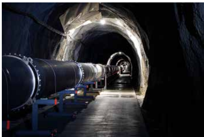
▲完成したKAGRAの内部
