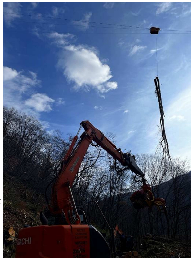
（タワーヤーダーによる集材）
