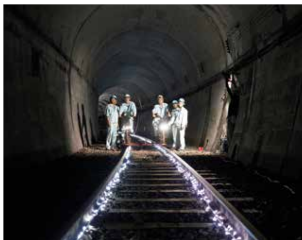
イルミネーションが設置されたトンネル内
