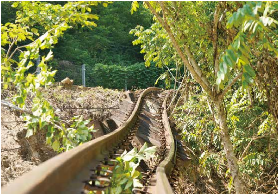
●大規模な土砂によって流されたJR高山本線の線路(宮川町牧戸地内)
